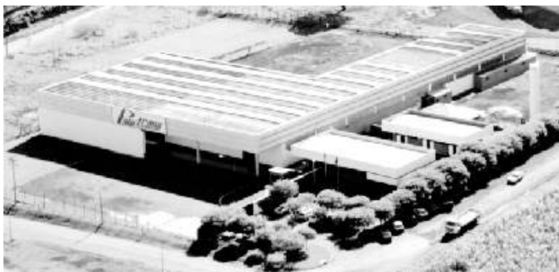
Paletrans Equipamentos Ltda - Unidade Cravinhos - SP
